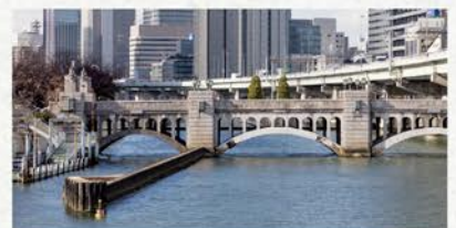
水晶橋(大阪公式観光情報より引用) 写真左側、川中の防波堤みたいなものが可動堰の名残
